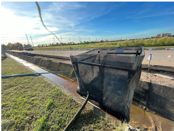
จัดทำตะแกรงสำหรับปล่อยน้ำ Hydrostatic Test
